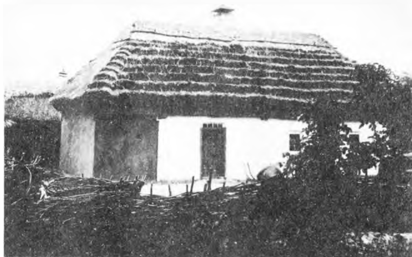
165. Украинский жилой дом с соломенной крышей. Полтавская губ. (замена, из фондов ГМЭ)
